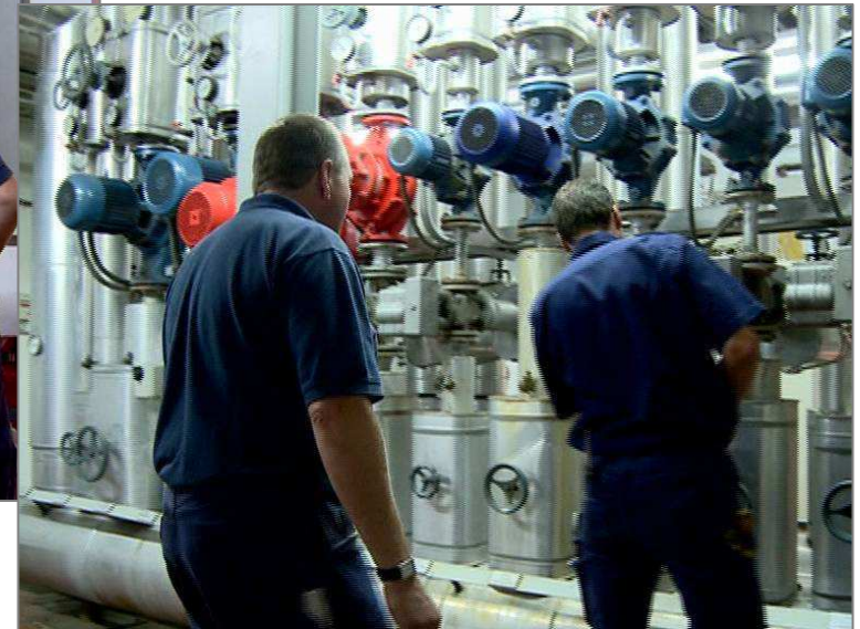
Wartung einer Heizungsanlage
