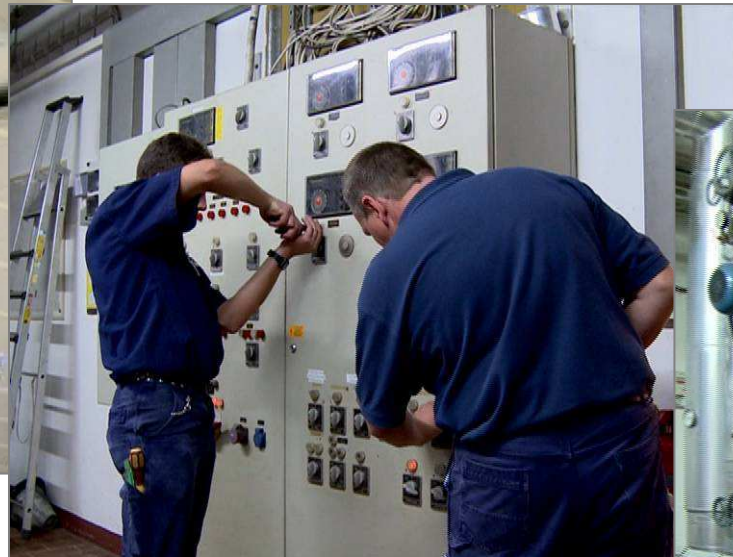
Wartung eines Stromschaltschranks
