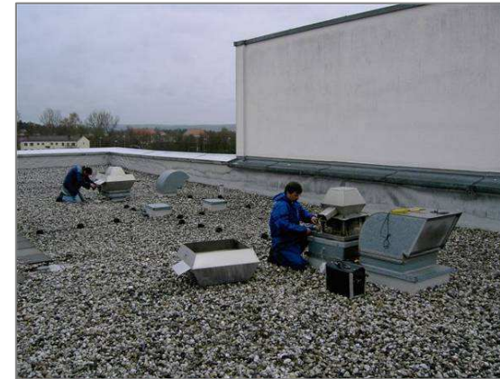
Reinigung von Abluftmotoren
