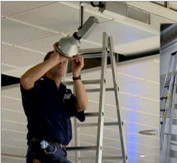
Tausch eines Glühelementes
